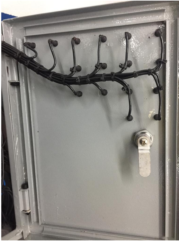
Figura 36 e 37 – Conexão elétrica dos bornes na cabine do painel.
