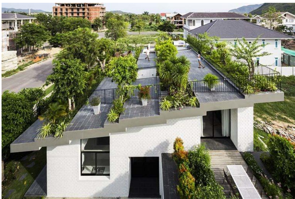
Figura 14 – Telhado Verde Intensivo.
