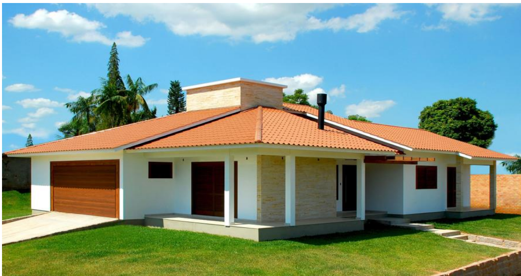
Figura 2 – Telhado de telha de cerâmica.
