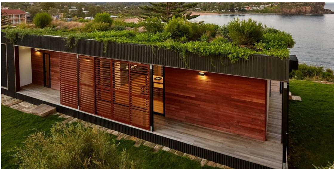
Figura 15 – Telhado Verde Semi-intensivo.
