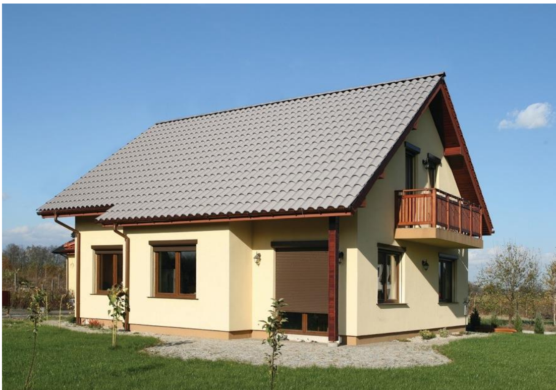
Figura 1 – Telhado com telha de fibrocimento.
