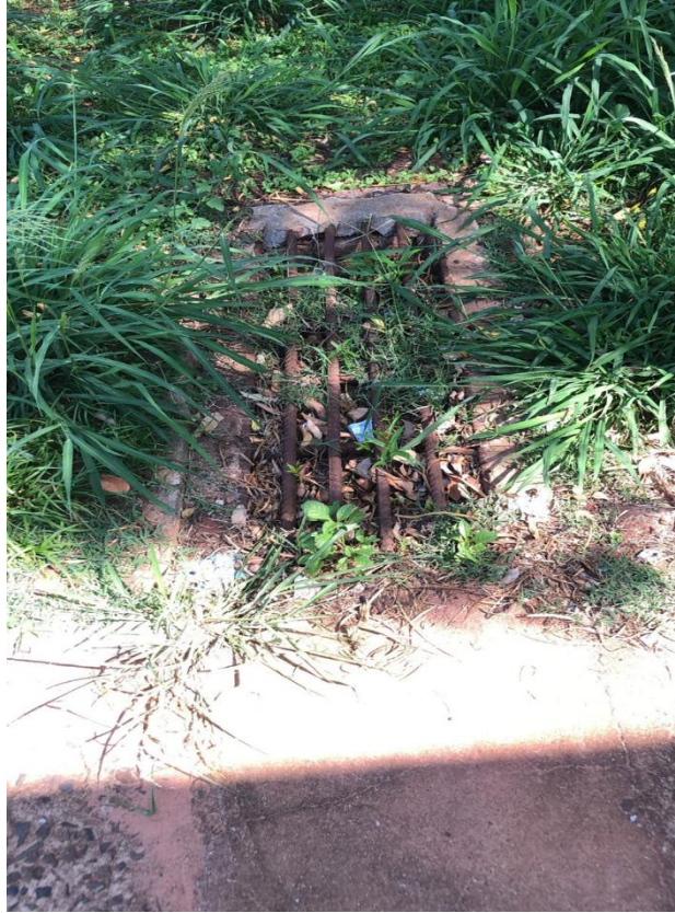
Fotografia 13 - Canaleta entupida.
