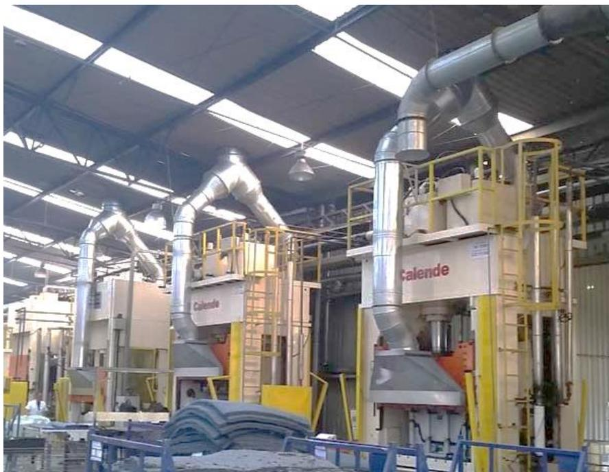
Figura [03]: Redes de dutos ligadas aos pontos de captação das máquinas. [6]
