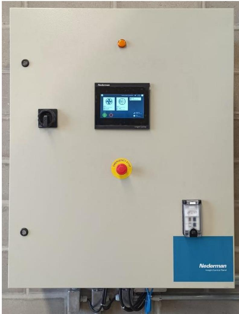
Figura [08]: Painel de comando para sistema de exaustão.<sup>[13]</sup>
