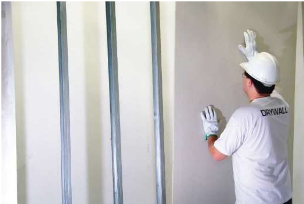
Figura 21 – Colocando uma parede de Drywall
