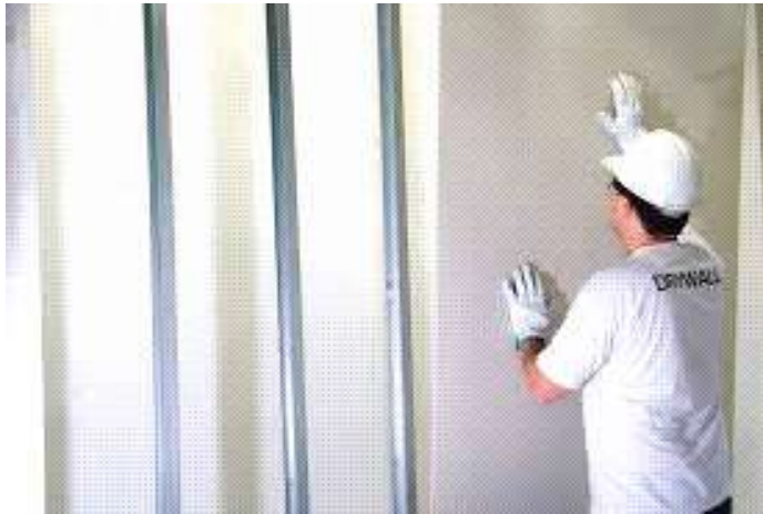
Figura 32 – Mostrando a colocação de uma parede de Drywall
