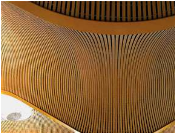
Figura 12 - Cobertura curvilínea de estrutura de aço e chapas de alumínio, forrada com bambu
