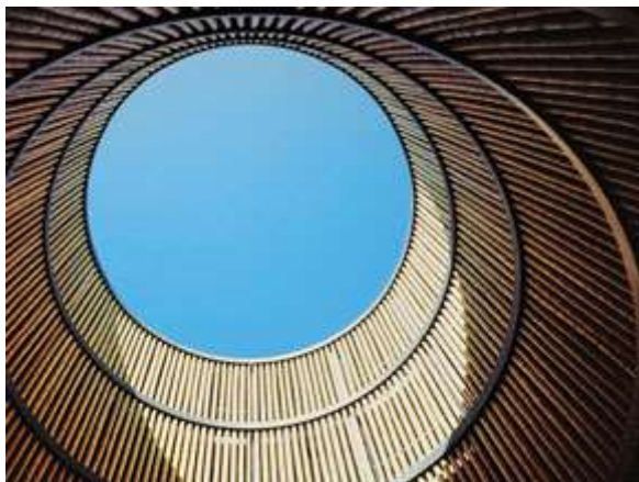
Figura 11 - Abertura zenital redonda localizada sobre as rampas de acesso do estacionamento
