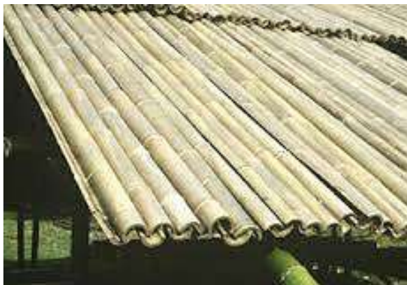
Figura 33 – Telhado de bambu feito em meia cana
