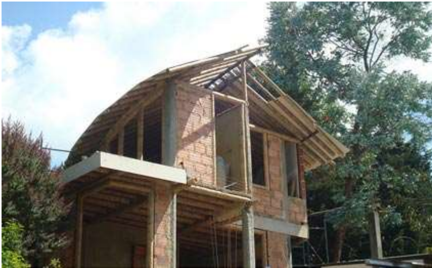
Figura 01 - Bambu utilizado na estrutura de uma residência.
