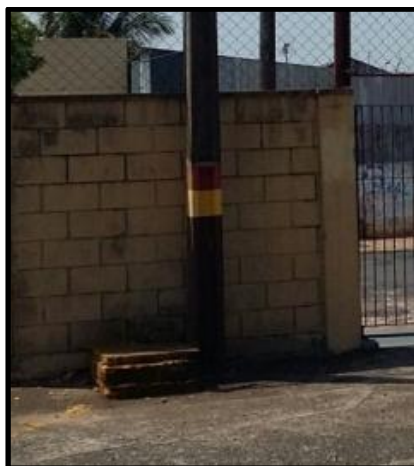
Figura 19 - Saída de Esgoto (Fonte: Pesquisadores)
