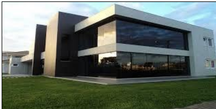
Figura 13 - Exemplo de Painéis e Vidros Instalados
