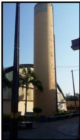
Figura 18 - Reservatório de Abastecimento de Água (Fonte: Pesquisadores)
