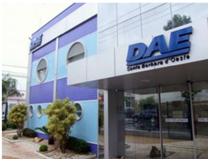
Figura 2 - Sede da Autarquia.
