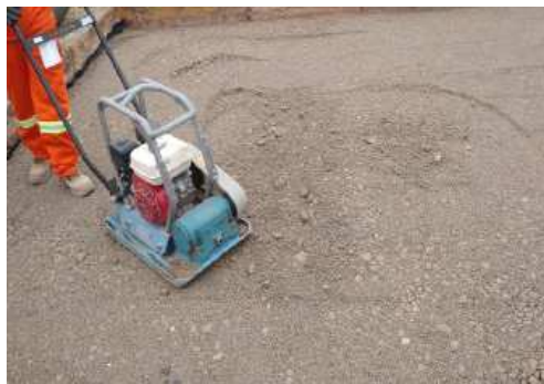
iv. Execução da base RCD
