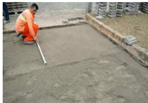
vi. Nivelamento da areia de assentamento
