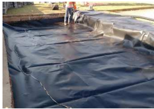
ii. Colocação de geomembrana
