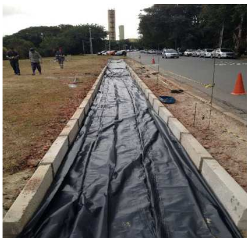
i. Colocação manta PEAD
