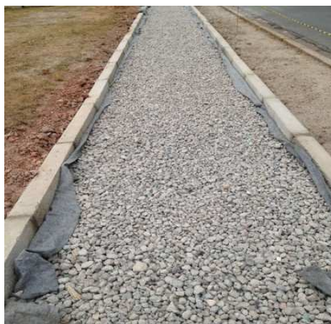
ii. Colocação e regularização da base com RCD
