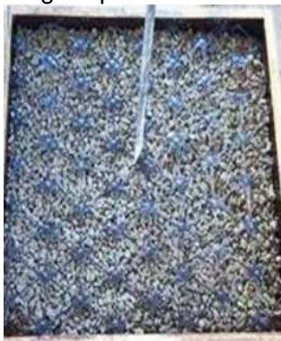
Figura 24 - Moldagem placa com malha geossintética
