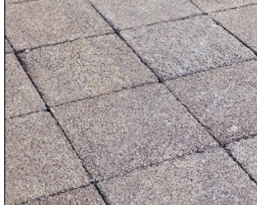
Figura 13 - Placas de concreto poroso
