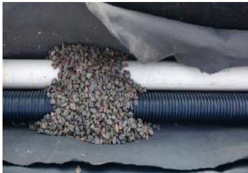
Montagem trincheira drenante
