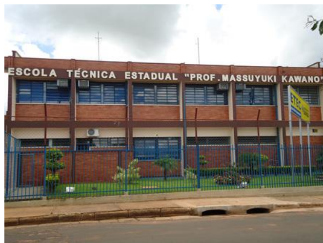
Figura 5- Imagem fachada da Escola Técnica Estadual Prof. Massuyuki Kawano
