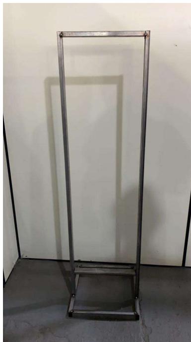
Figura 3 - Montagem da sustentação do totem.
