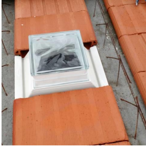
Figura 2 Instalação de Bloco de Vidro em Laje 1
