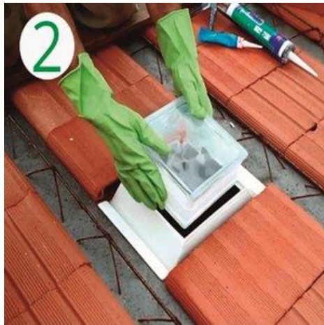
Figura 4 Instalação de Bloco de Vidro em Laje 1
