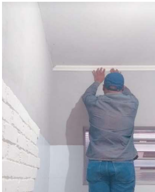
Figura 45: Instalação das molduras de isopor.
