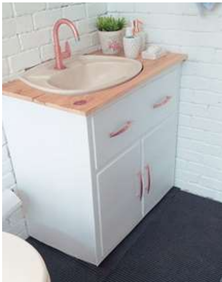
Figura: Gabinete instalado.
