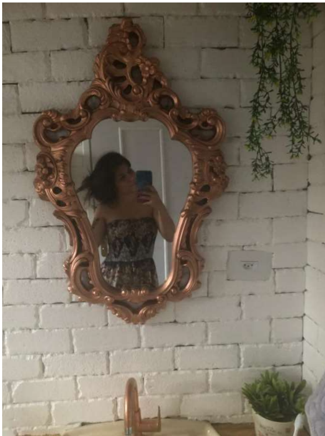
Figura: Reformulação de banheiro em imóvel alugado com baixo custo concluída.
