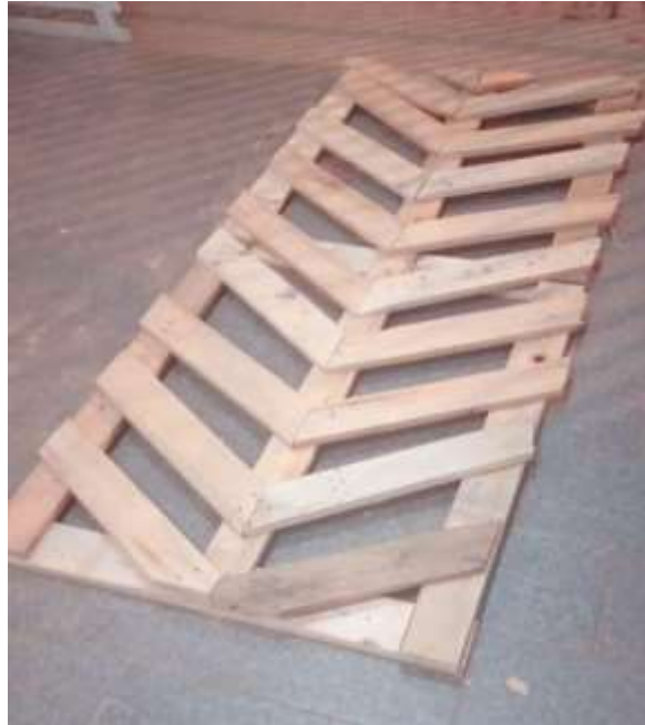
Figura: Divisória pronta para ser pregada.
