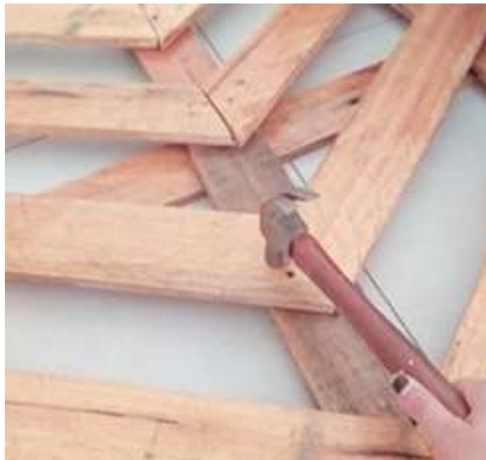
Figura: Fixação das madeiras com pregos.
