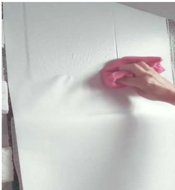
Figura 41: Colagem do plástico adesivo.
