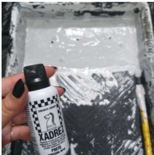
Figura 10: Mistura do corante preto na tinta branca para obtenção da cor cinza no tom desejado.
