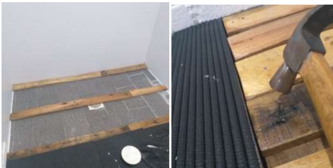
Figura: Instalação do deck.
