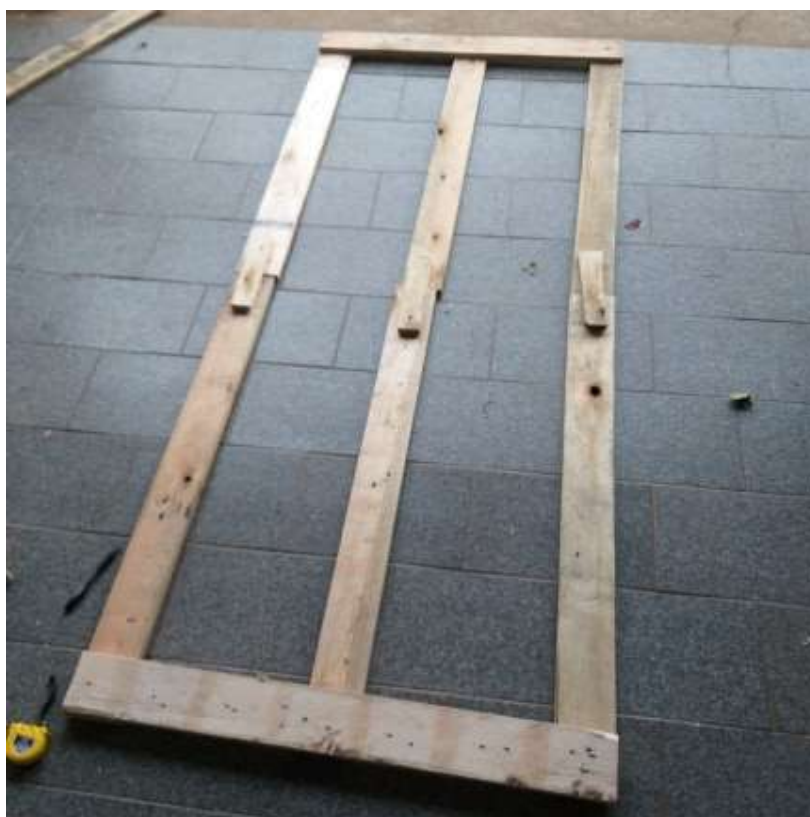
Figura: Estrutura para a montagem da divisória.
