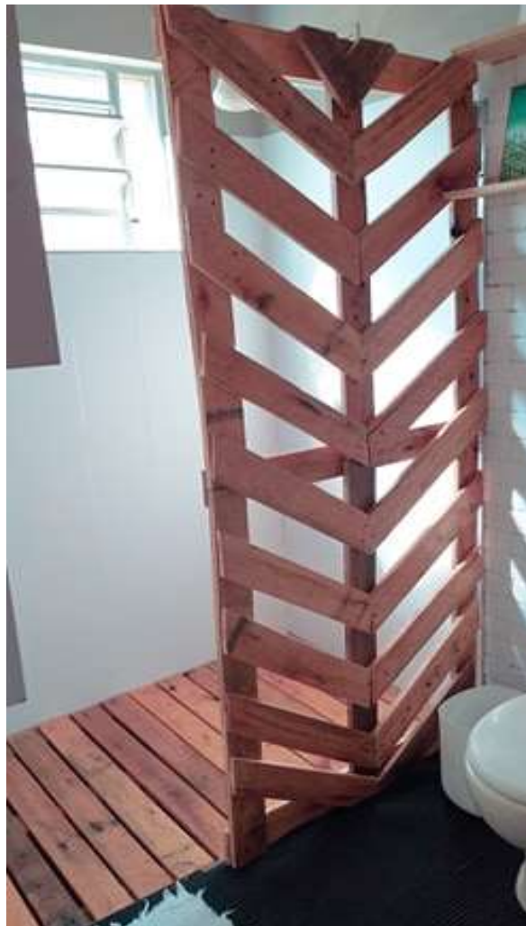
Figura: Divisória de madeira de pallets concluída.
