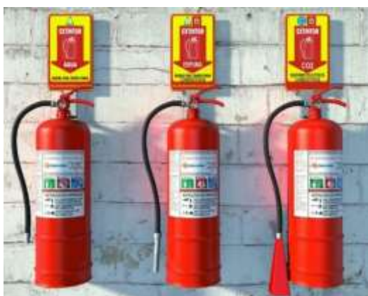
Figura 7: Extintor de incêndio (EPC)
