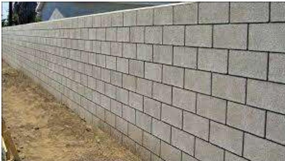
*Figura 59 - Muro em bloco estrutural*
