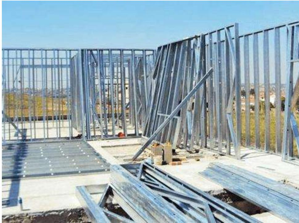
*Figura 19: Montagem dos painéis metálicos*
