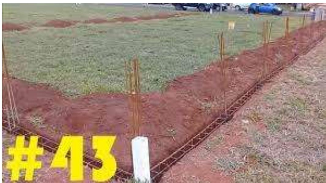
*Figura 58 Fundação do muro*
