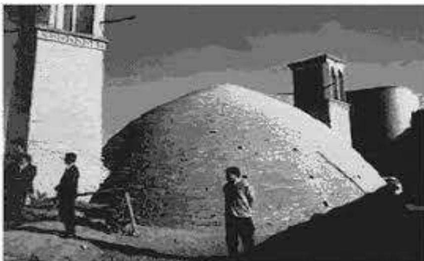
*Figura 30 - Abanbars, tradicional sistema de captação de água comunitario do Irã*
