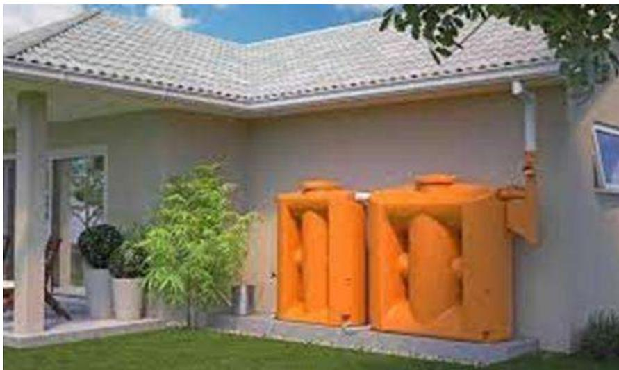
*Figura 13 - Cisterna Calha*
