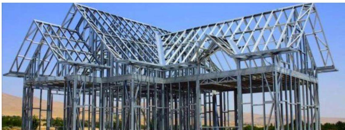
*Figura 15 – Estrutura em Light Steel Frame LSF*
