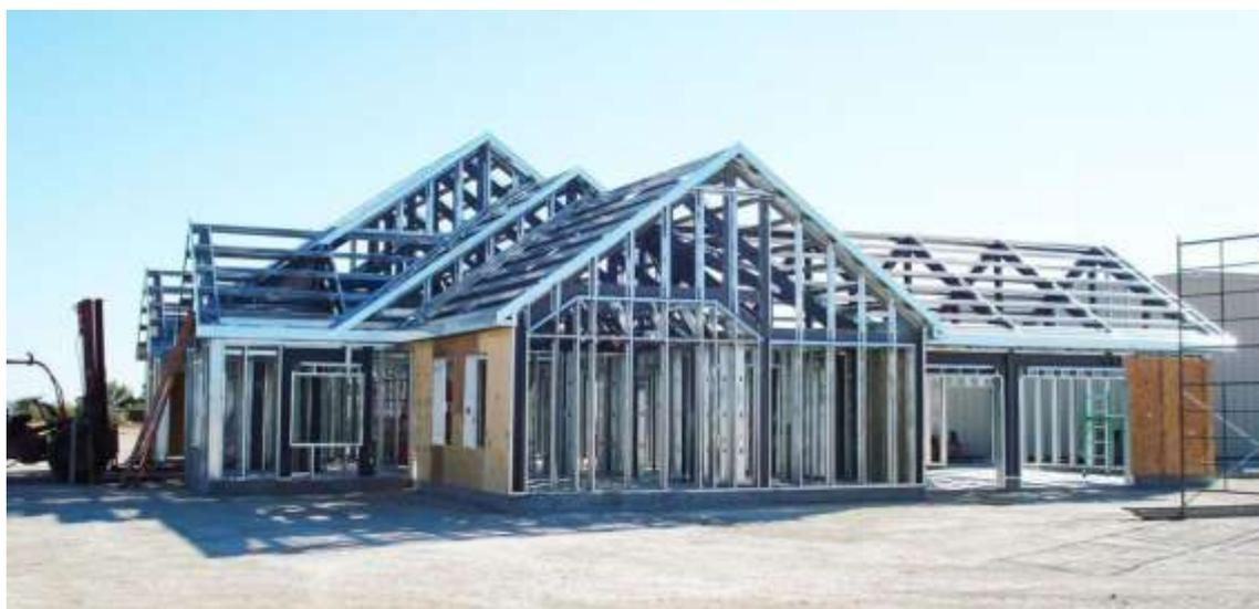
*Foto 17 - Estrutura de residência em light steel frame*
