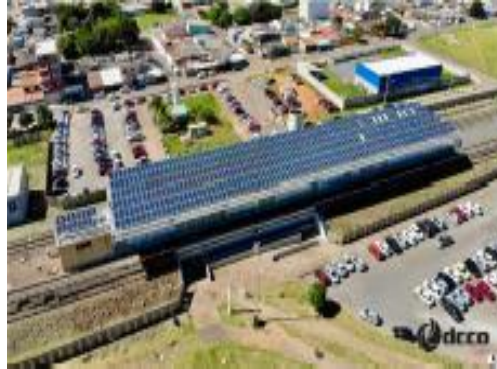
Figura 9 – Estação Solar Samambaia Sul.
