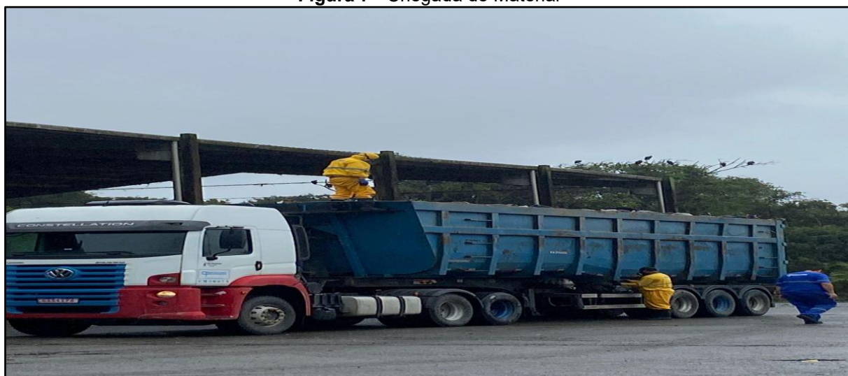
Figura 7 - Chegada de Material
