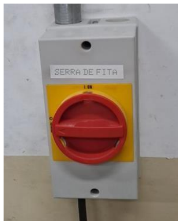
Figura 9 - Chave seletora lockout tagout
