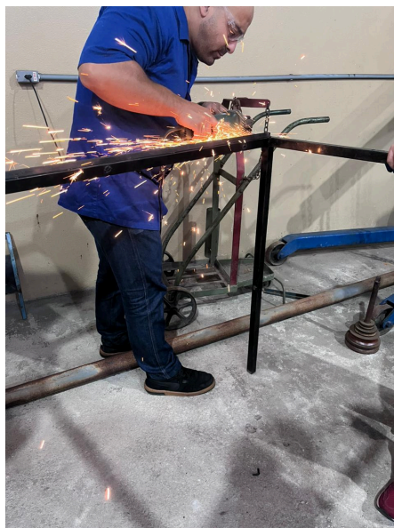
Imagem 4 - Corte das estruturas
