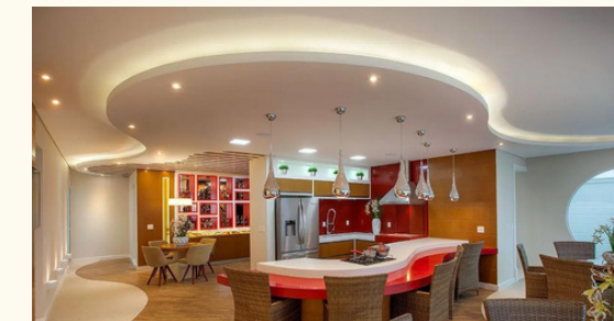
Forro de gesso, sanca invertida
