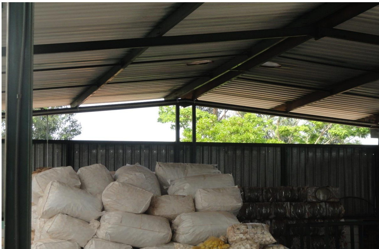
Figura 27. Laterais do depósito com aberturas para ventilação – ARIAR.
