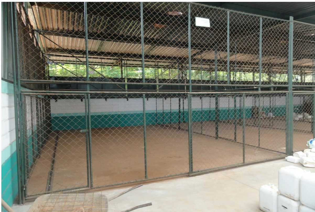
Figura 16. Baia de separação e armazenagem das embalagens – ARIAR.
