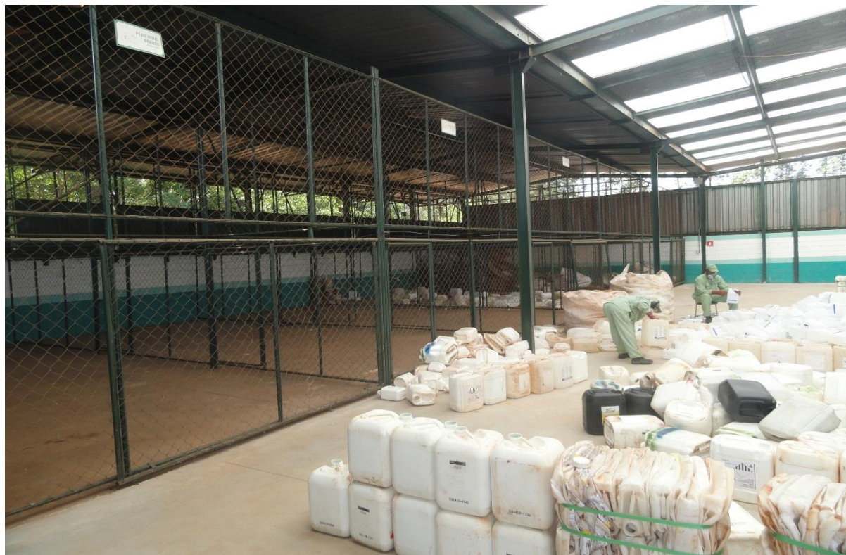
Figura 17. 06 Baias de separação e armazenagem das embalagens – ARIAR.
