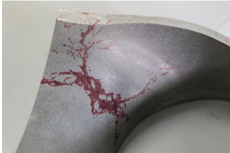
Figura 3 - Identificação de trincas por corrosão sob tensão via ensaio de líquido penetrante.
