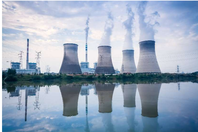
Figura 6 – Torre de tiragem natural.
