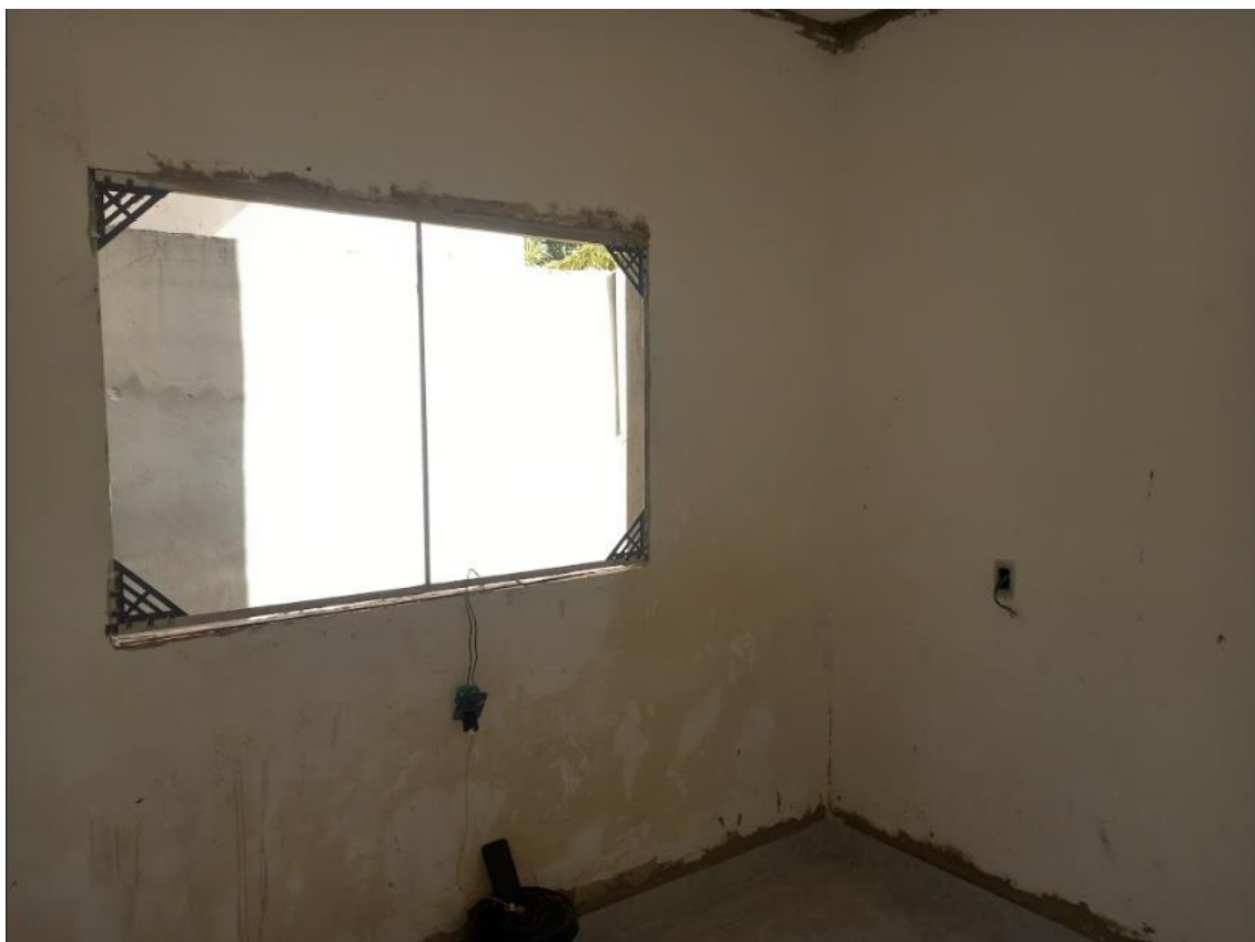
Figura 33: Instalação Elétrica Irregular
