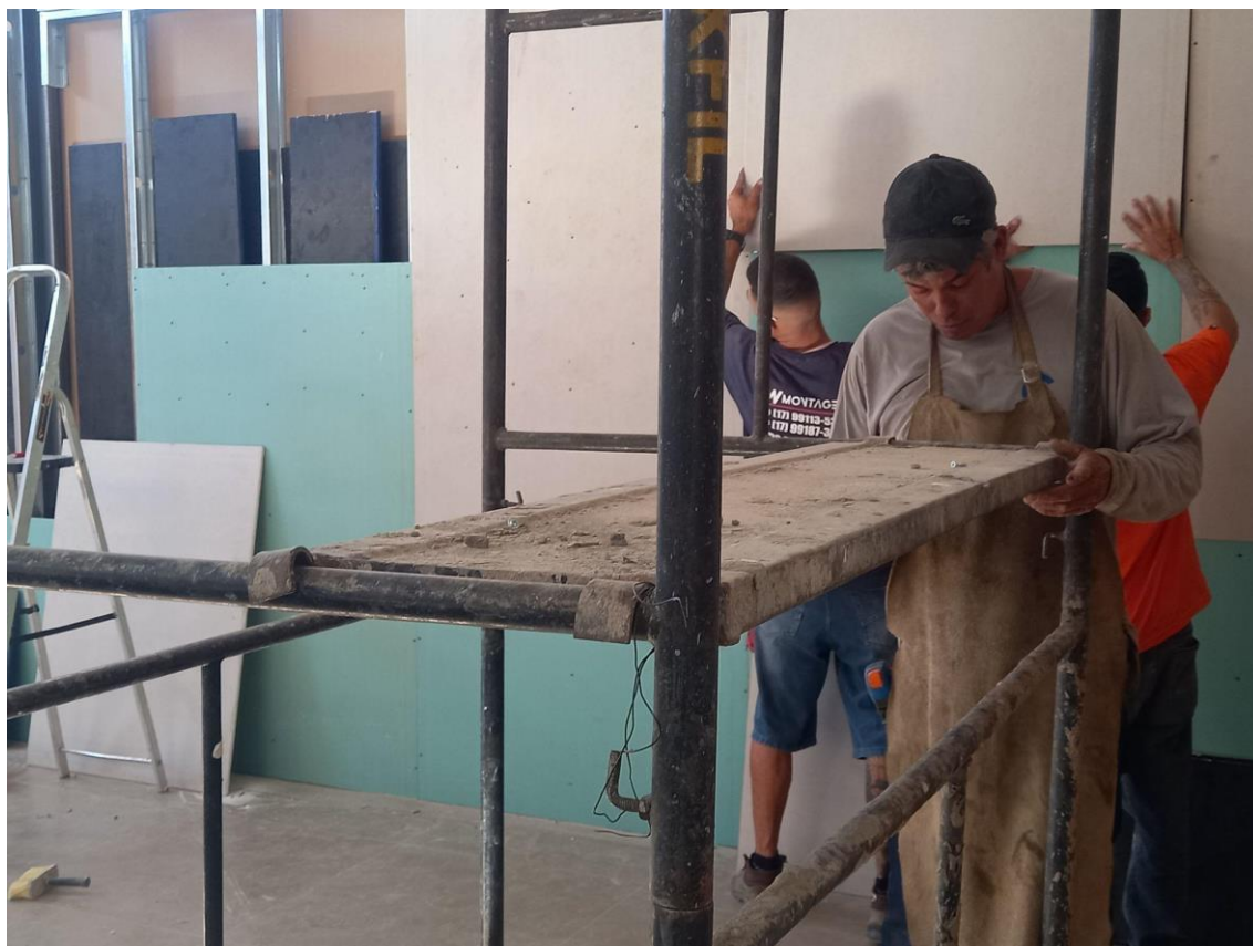
Figura 39: Trabalhadores sem Equipamentos de Proteção
