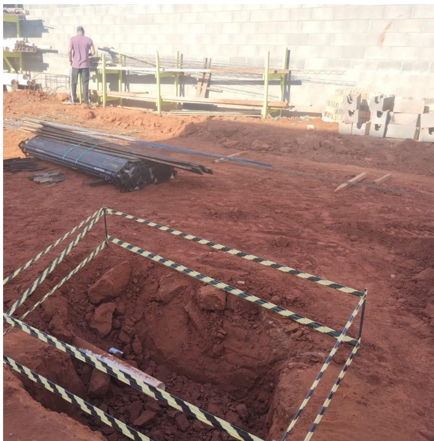
Figura 27: Sinalização Irregular de Escavação
