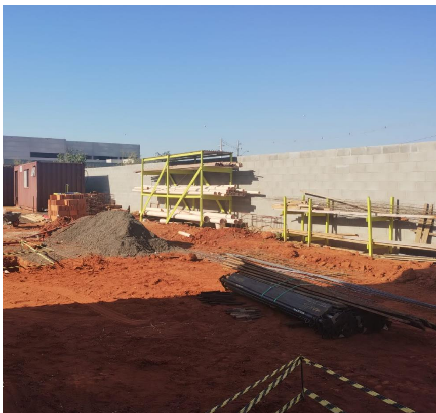
Figura 28: Armazenamento Inadequado de Materiais
