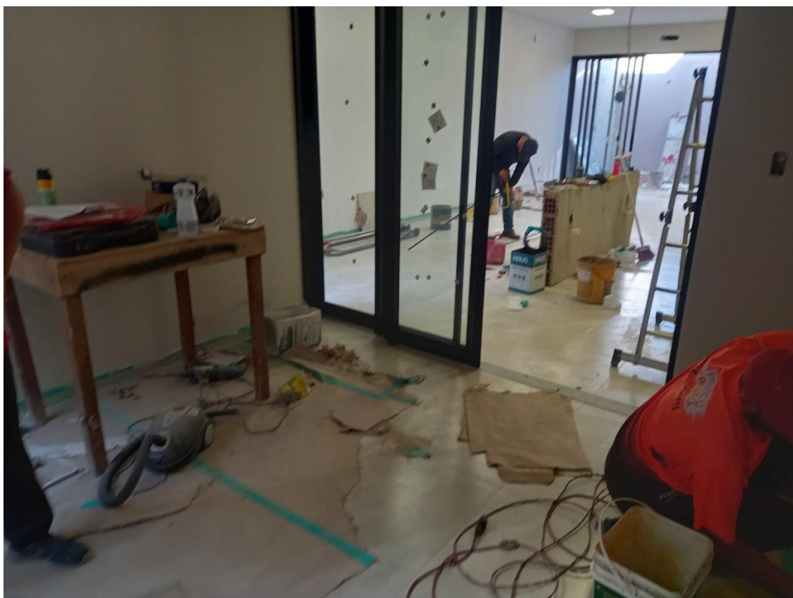
Figura 34: Desorganização e Ausência de Equipamentos de Proteção
