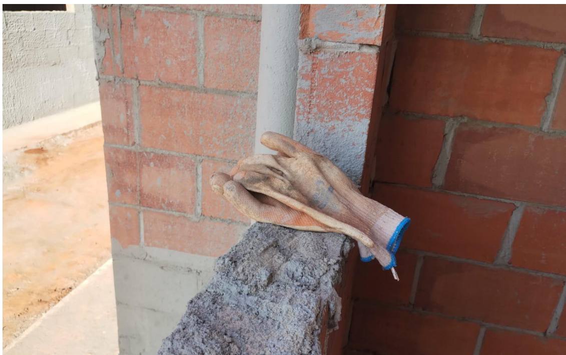
Figura 25: Armazenamento Inadequado de Luvas de Proteção
