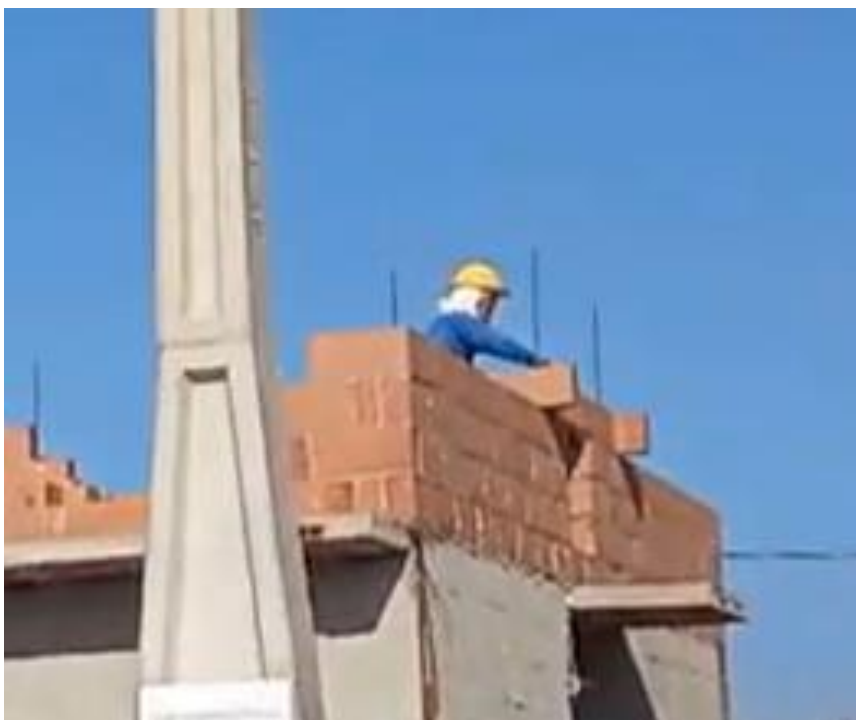
Figura 23: Trabalho em Altura sem Equipamentos de Proteção
