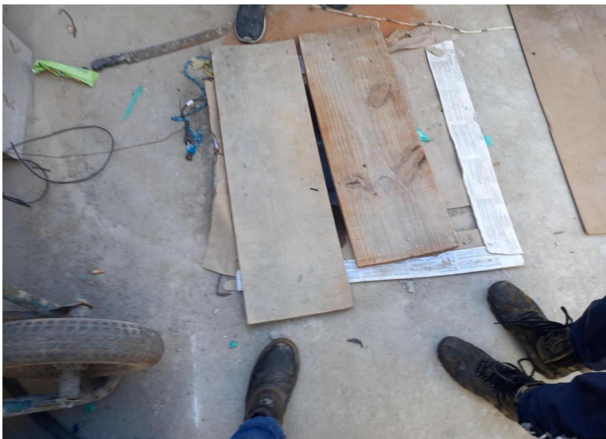
Figura 35: Cobertura Improvisada de Escavação
