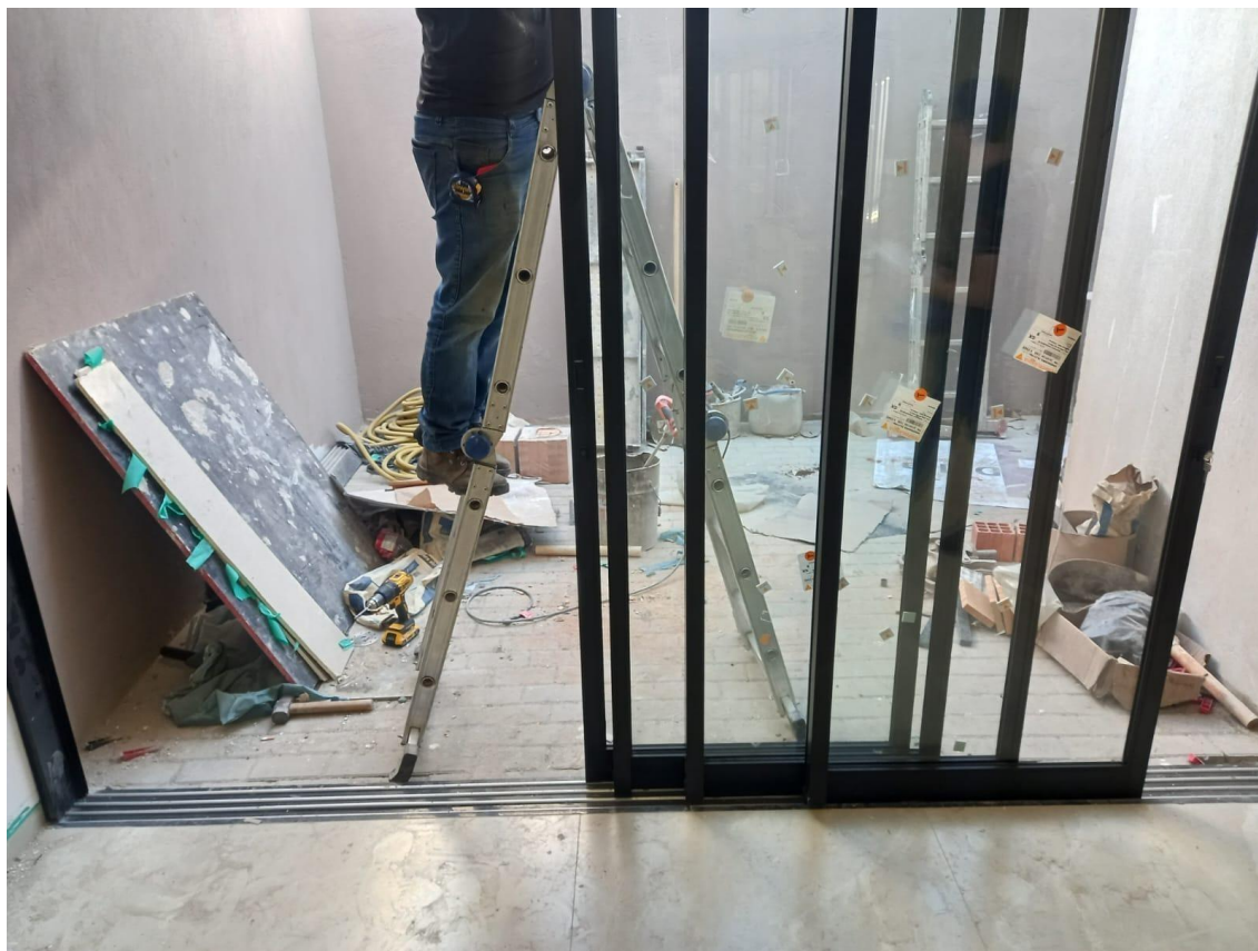
Figura 36: Utilização Inadequada de Escada
