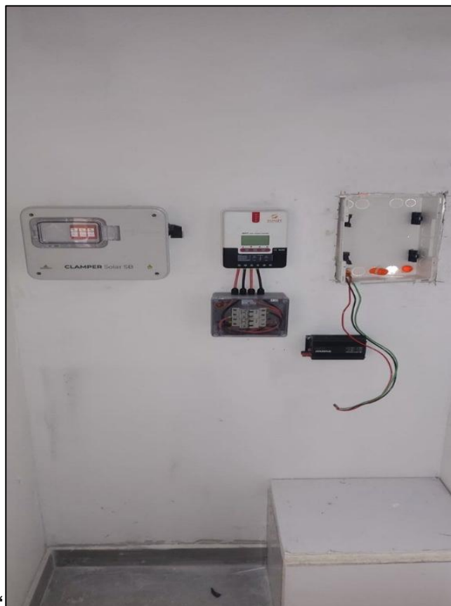
Figura 26: montagem String Box, regulador de carga e quadro de proteção do banco de baterias.
