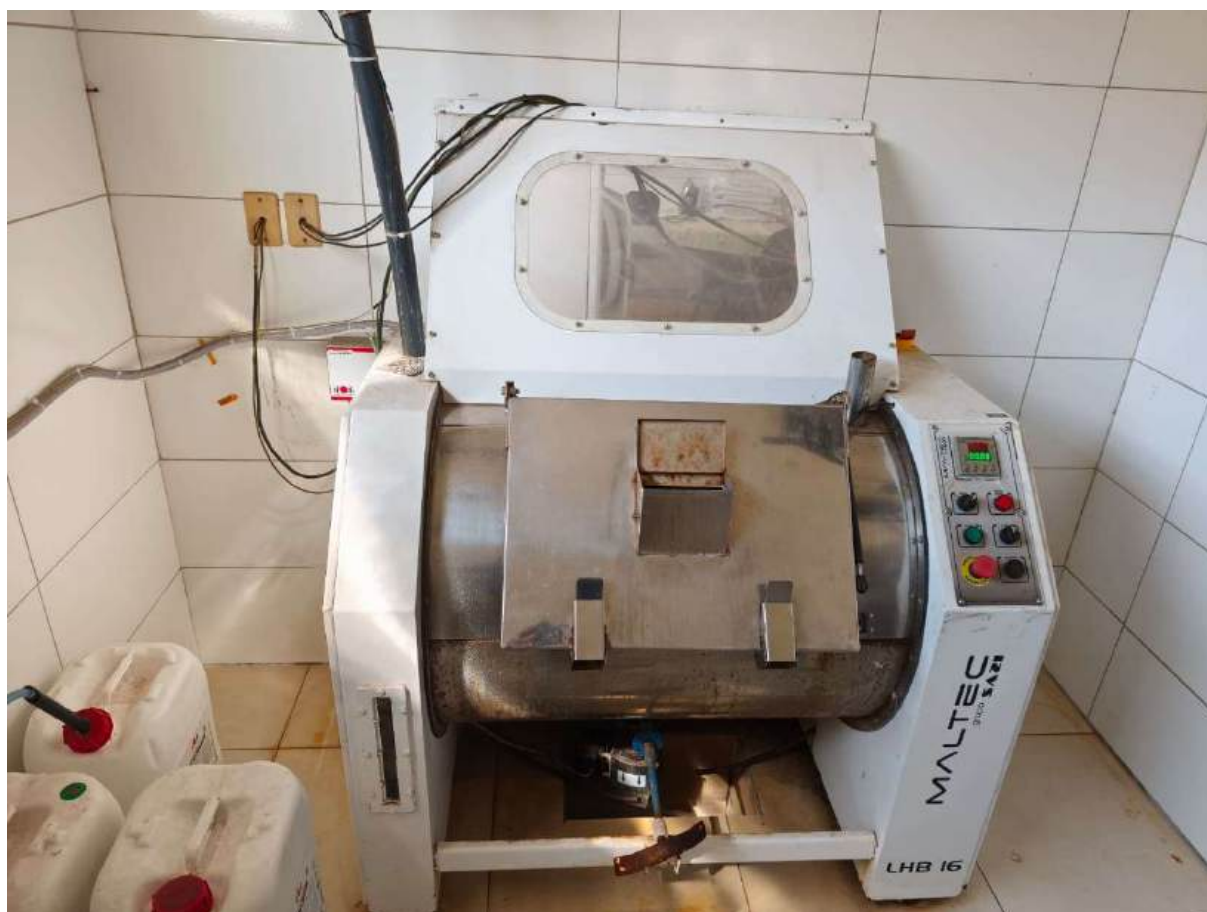
Figura 6: Lavadora horizontal com barreira (entrada)
