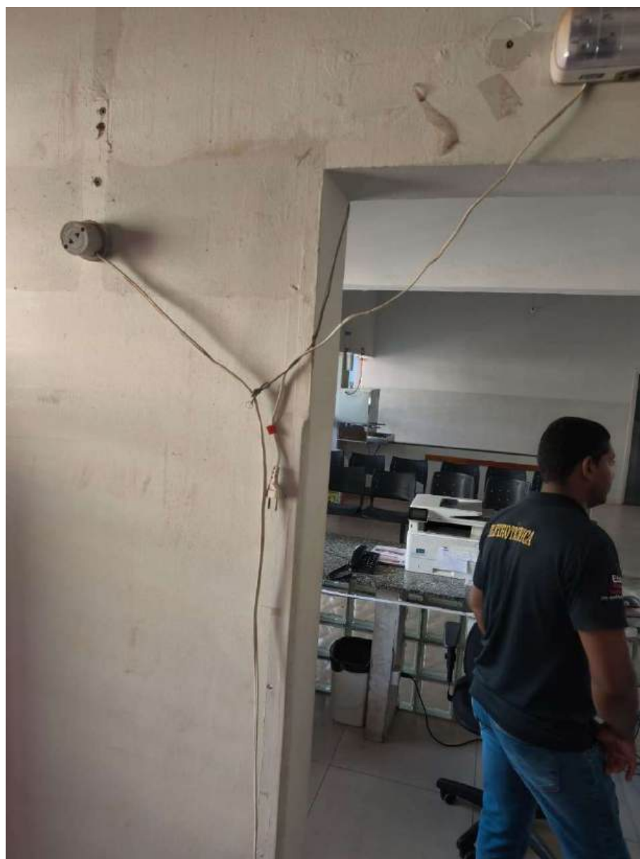
Figura 10: Iluminação de emergência e tomada
