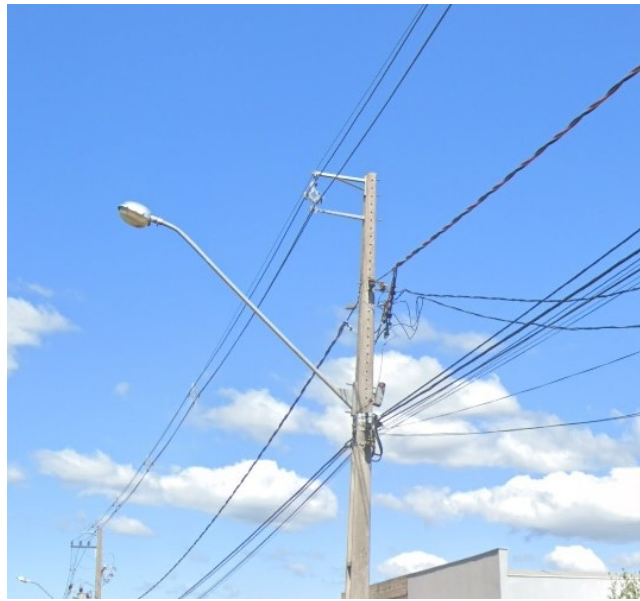
Figura 12 - Estrutura CE1 com braço anti balanço
