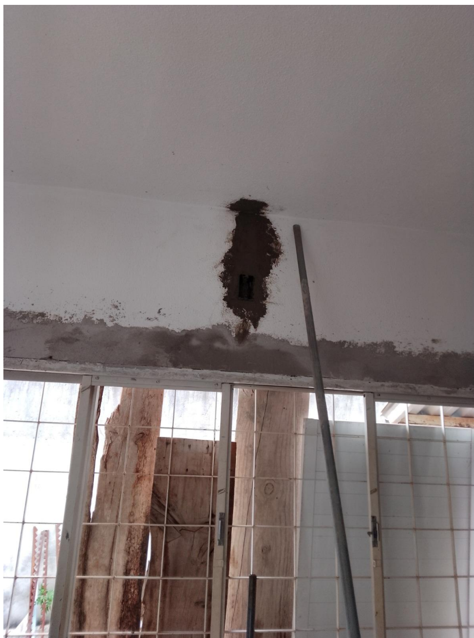
Imagem 15 - Chumbamento da caixa de passagem
