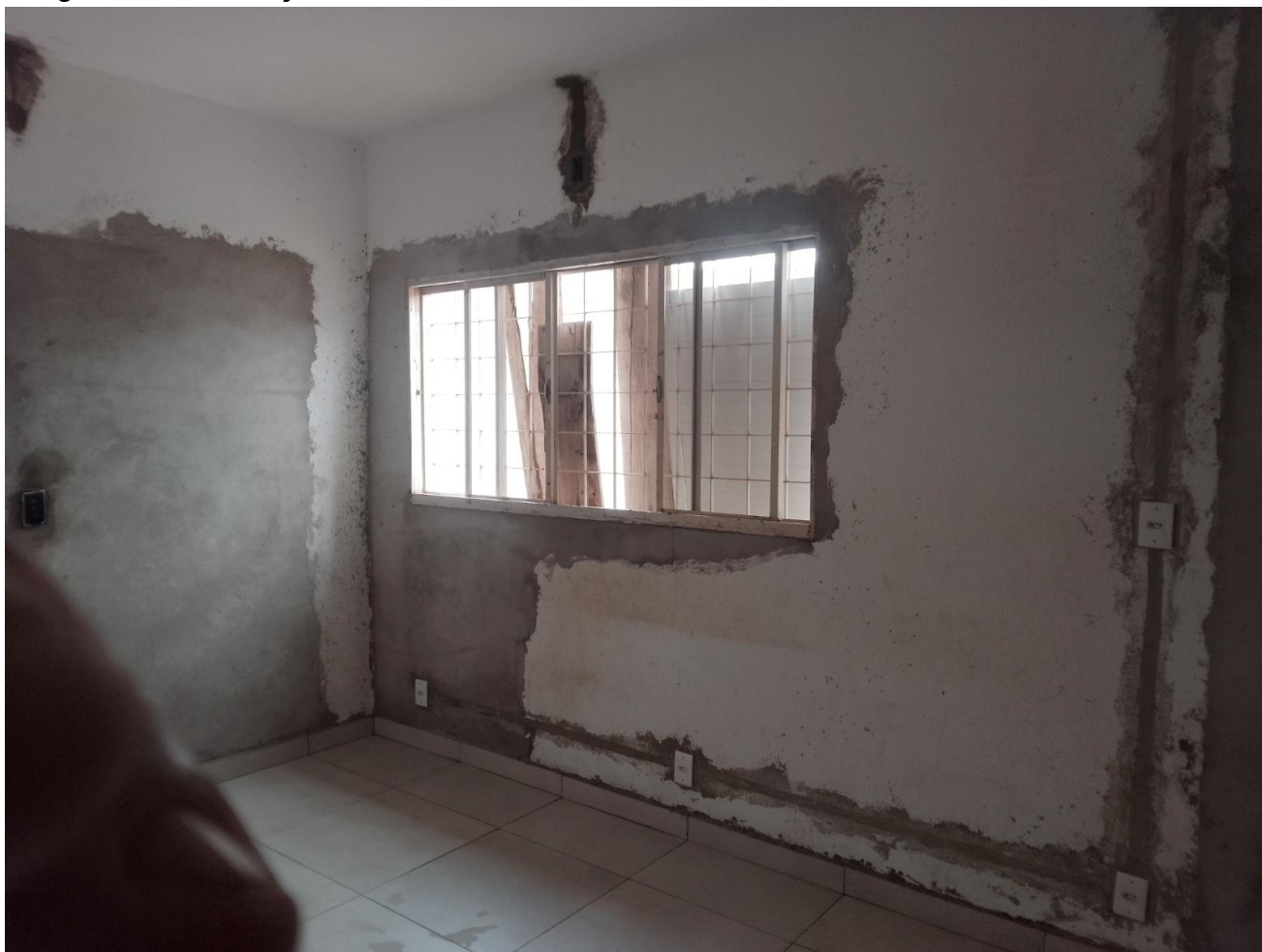
Imagem 17 - Instalação das novas tomadas
