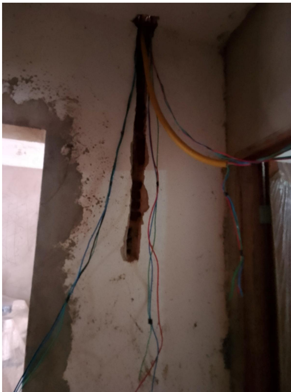
Imagem 9 - Definição do novo local para o quadro de força e luz (QFL)
