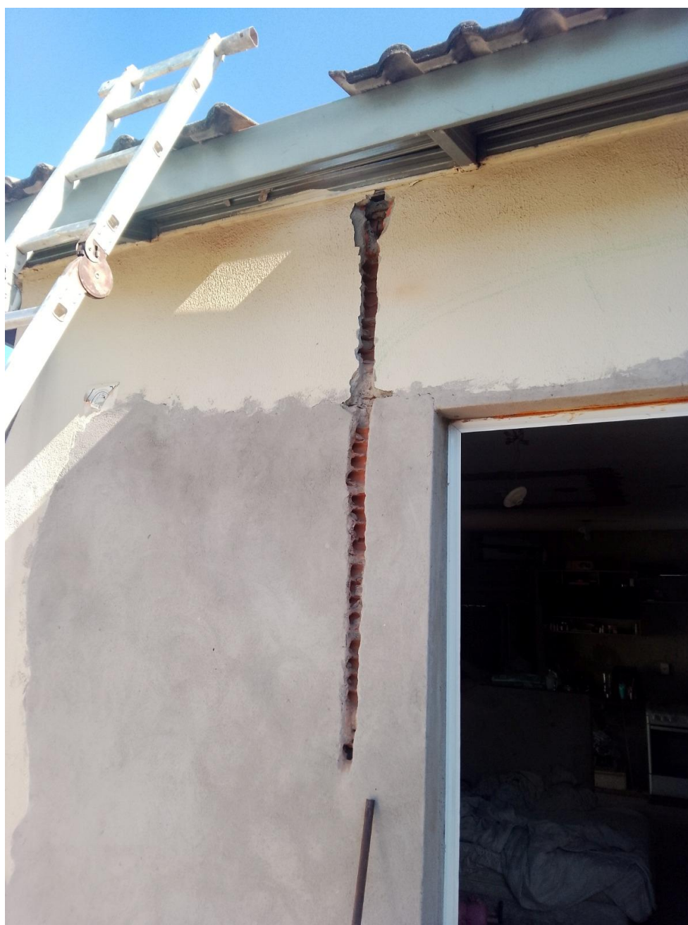
Imagem 11 - Detalhe do corte na parede e laje
