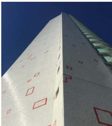
IMG. 02 – Mapeamento das fachadas do edifício
