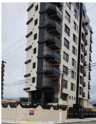
IMG. 06 – Instalação de placa da empresa para mapeamento da fachada
