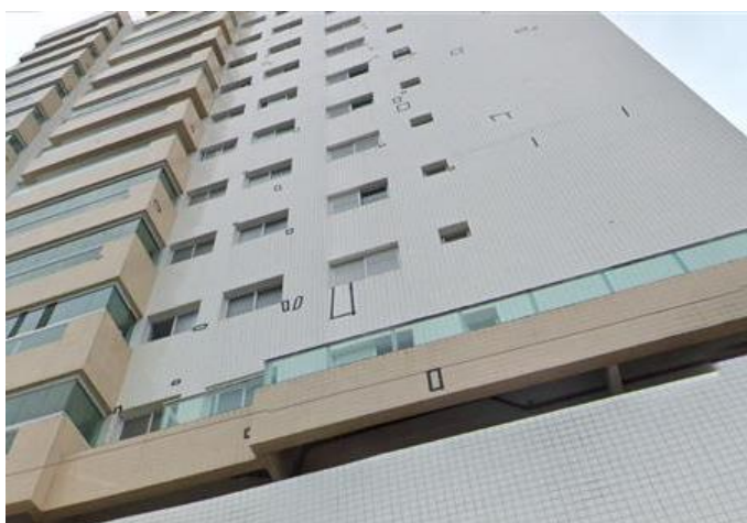
IMG. 05 – Mapeamento das fachadas do edifício
