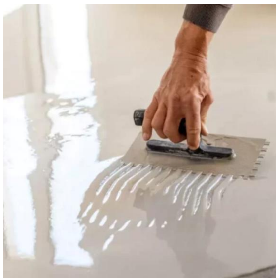
Figura 10 – Piso líquido de Epoxi autonivelante
