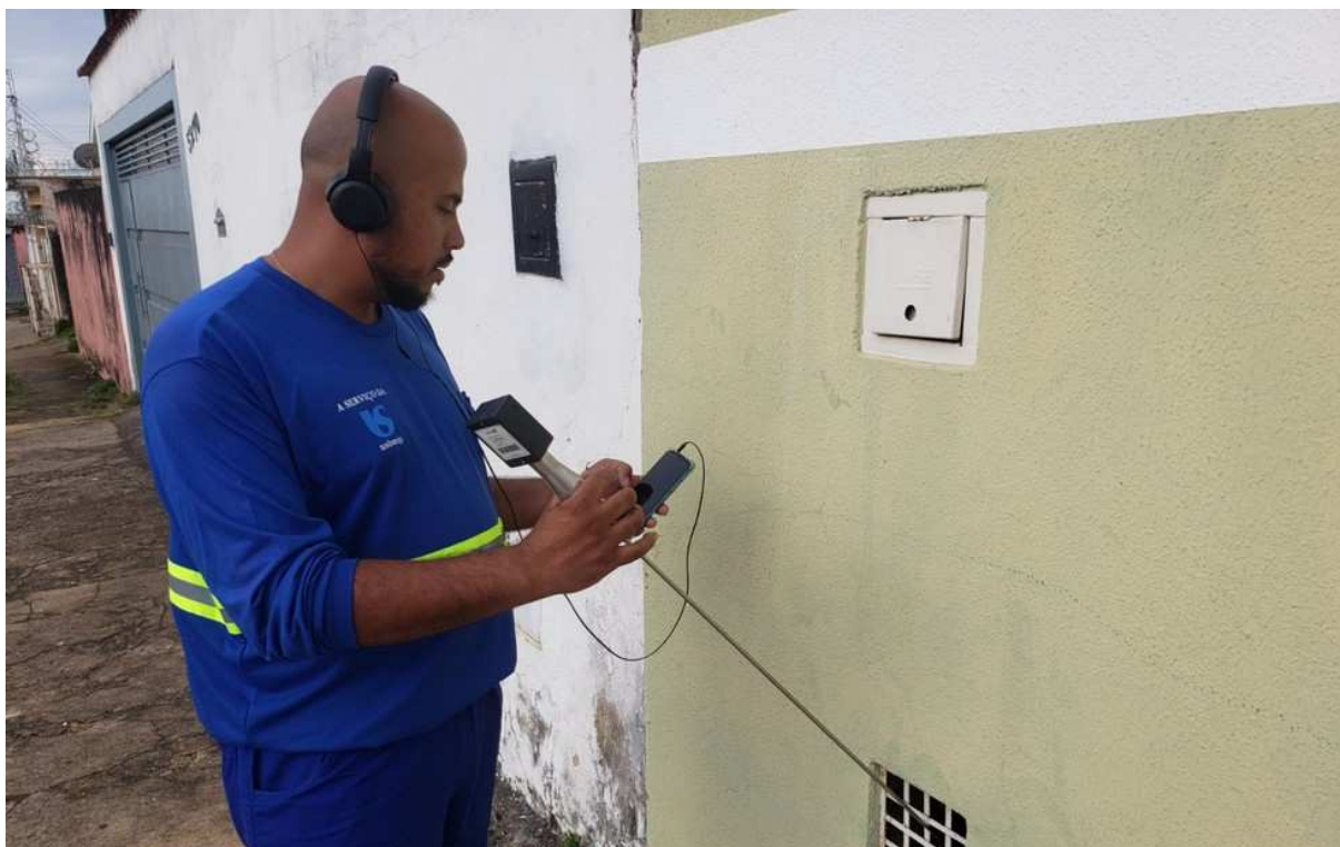
Figura 2-16 - Geofonista realizando coleta de sons no Hidrômetro do imóvel
