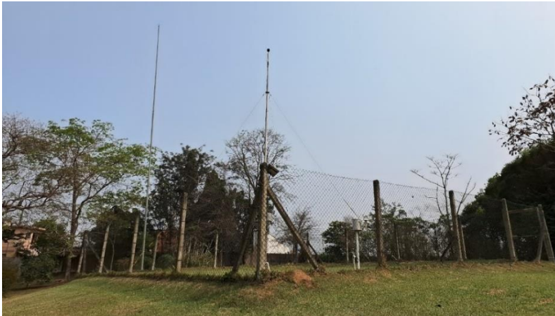
Figura 18: Vista da Estação automática INMET - Interlagos, localizada dentro do SESC Interlagos - SP
