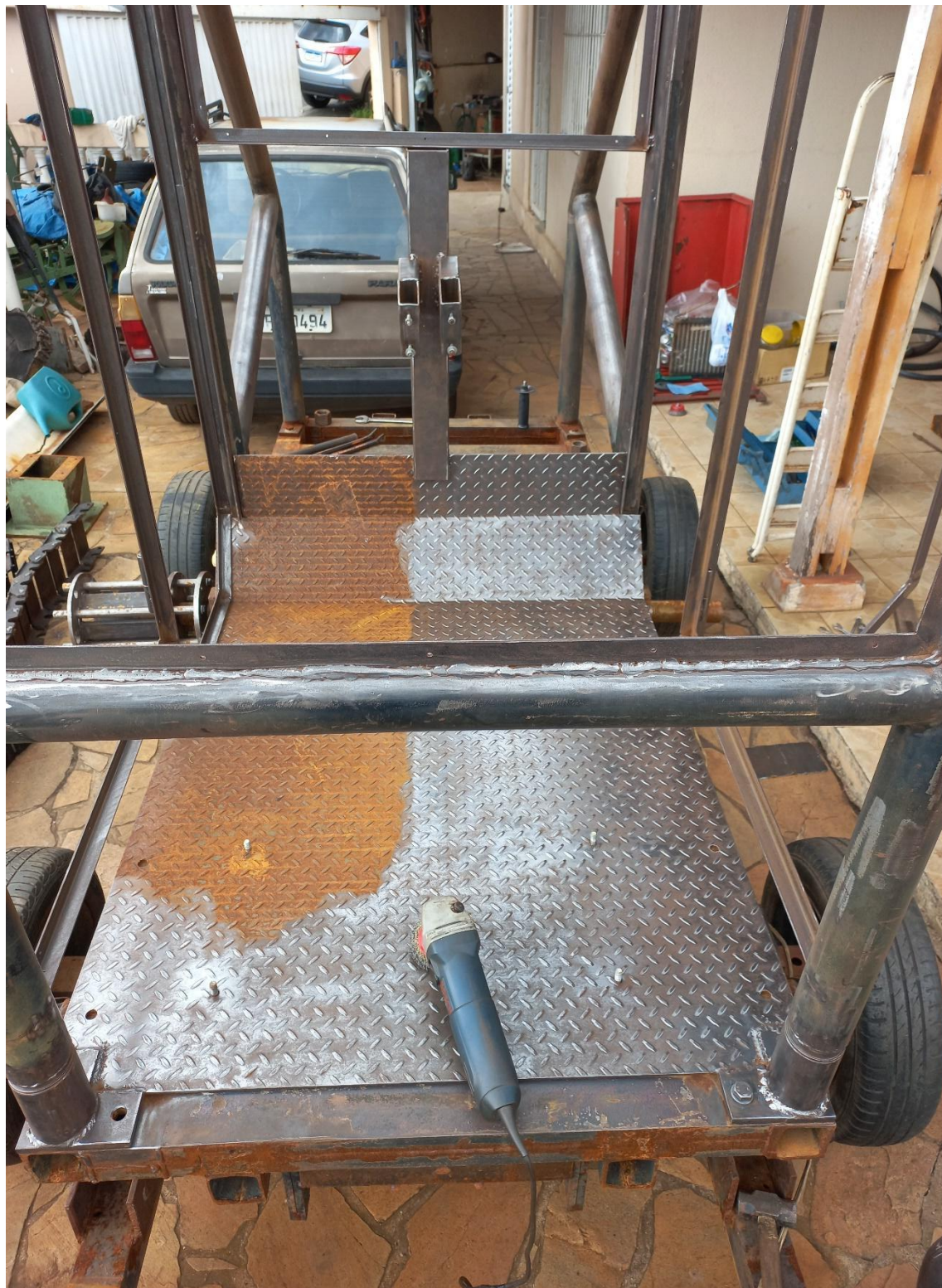
Figura 22-Remoção da ferrugem
