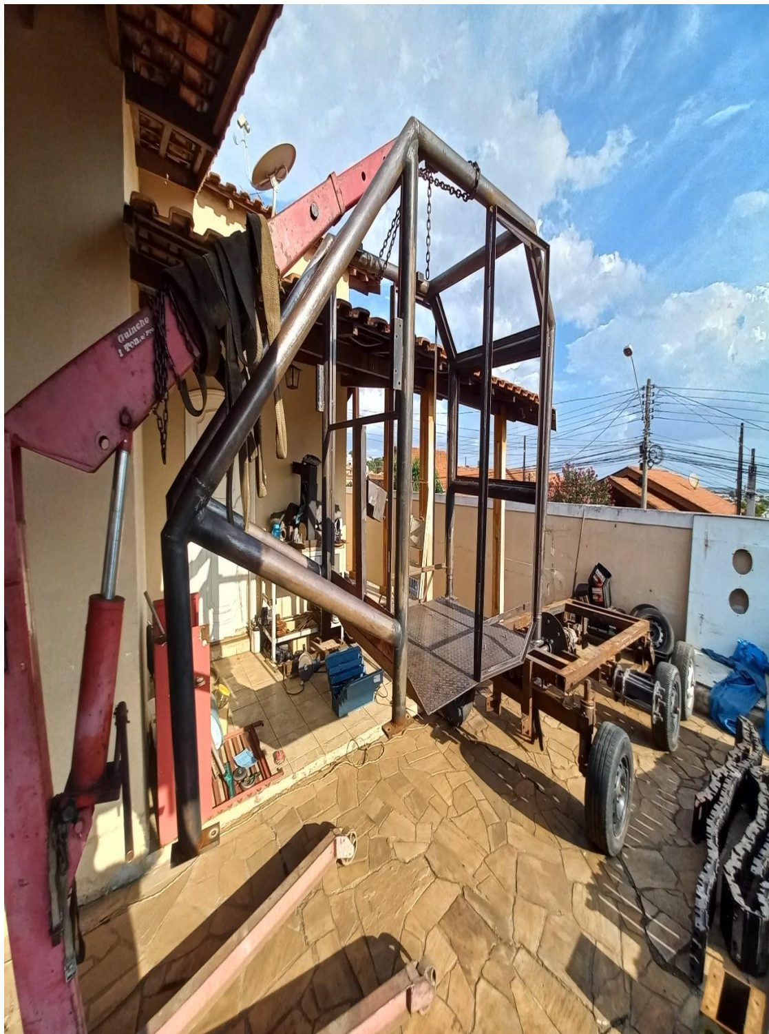
Figura 23-Içamento da estrutura
