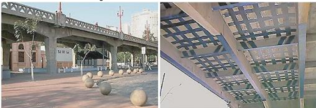
Figura 19 – Viaduto de Santa Teresa.
