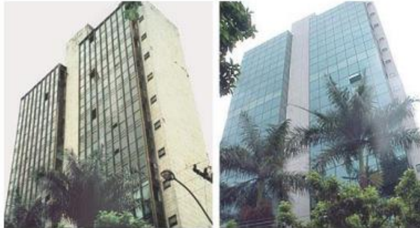
Figura 26 – Edifício anexo III antes e depois.
