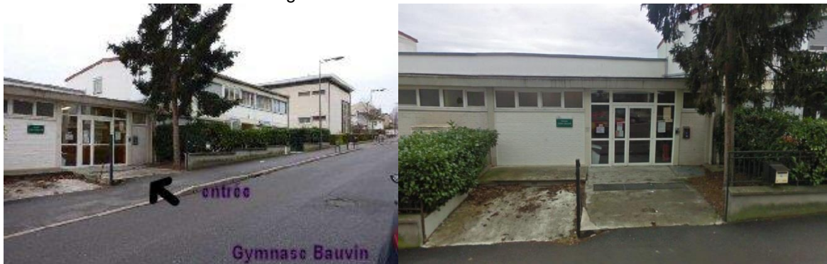
Figura 12 – Ginásio Gilbert Bauvin.
