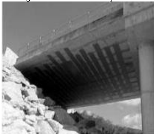
Figura 21 – Viaduto em Aymorés.
