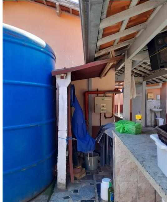
Foto: Painel de controle da água obstruído/Fonte: Autores, 2024
