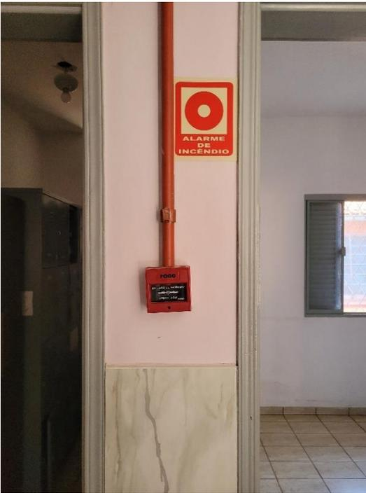
Foto: Alarme de incêndio devidamente sinalizado/Fonte: Autores, 2024
