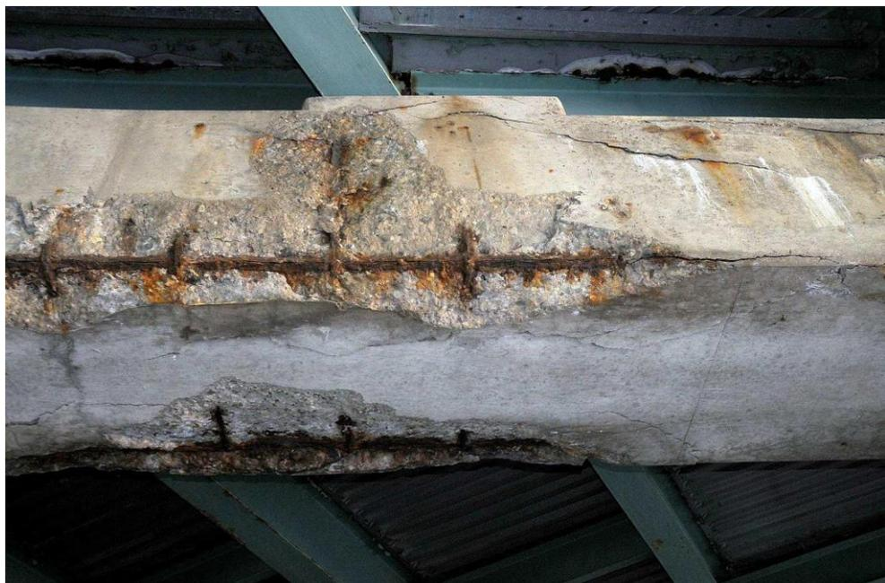
**Figura 15** – Corrosão da armadura por carbonatação.
