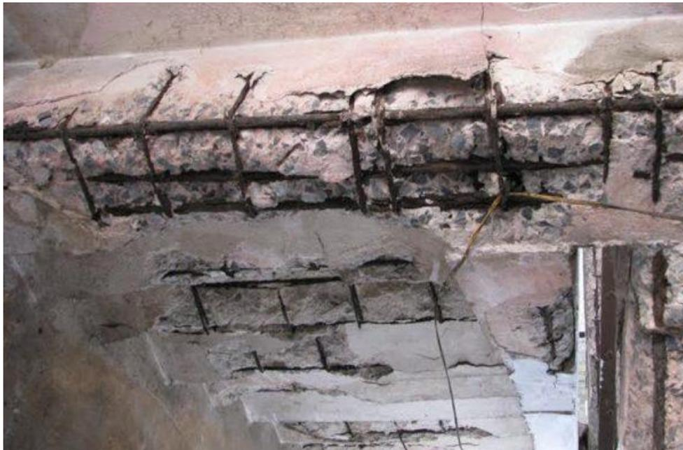
**Figura 13** – Corrosão de armadura.
