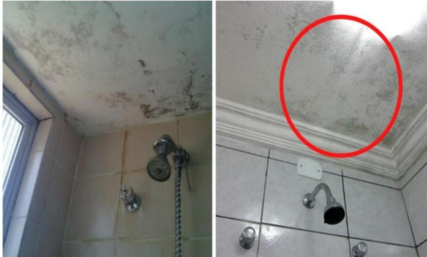
**Figura 4** - Umidade por condensação em banheiro.
