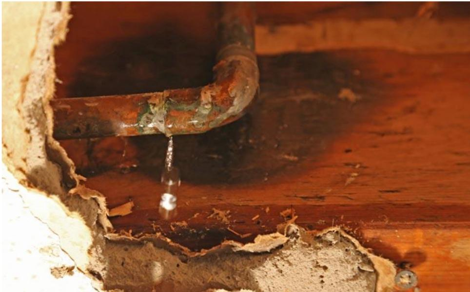
**Figura 8** – Vazamento de tubulação.
