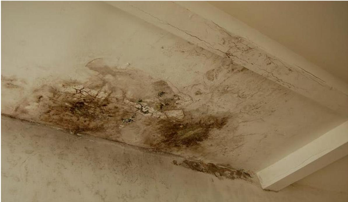
**Figura 2** - Infiltração em laje
