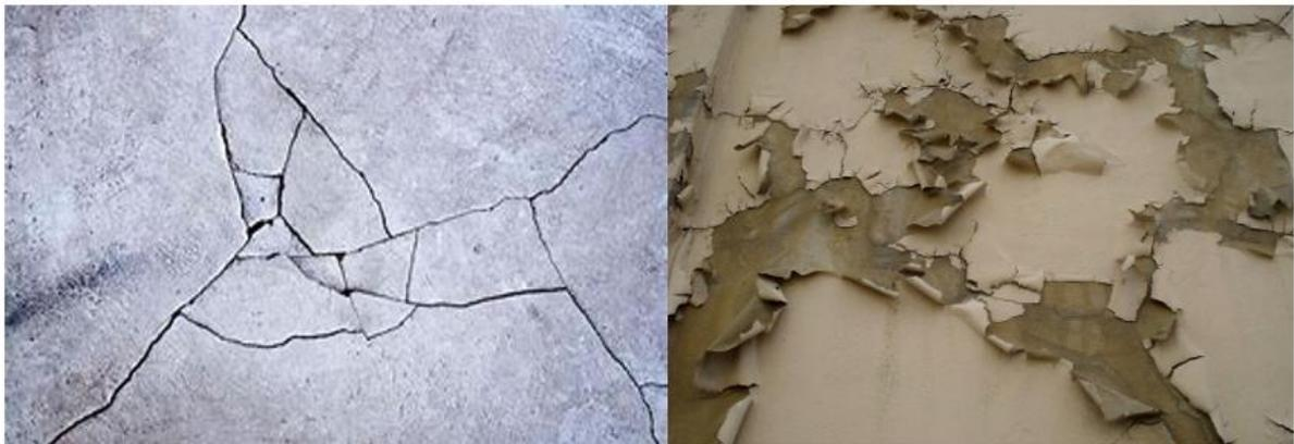
**Figura 12** – Trinca em Revestimento e Degradação de Pintura.
