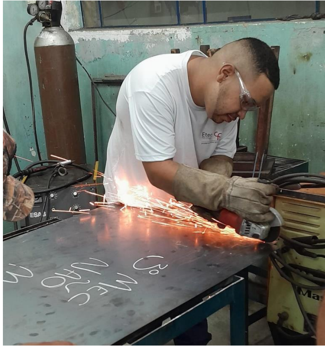
Figura 1 – CORTE DA CHAPA DE BASE DA MESA Fonte: Acervo pessoal
