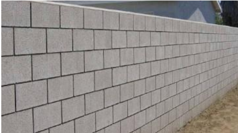
Imagem 6: Muro de Bloco
