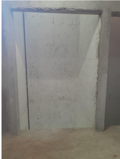
Foto 2: Foço do elevador aberto e sem proteção e com proteção
