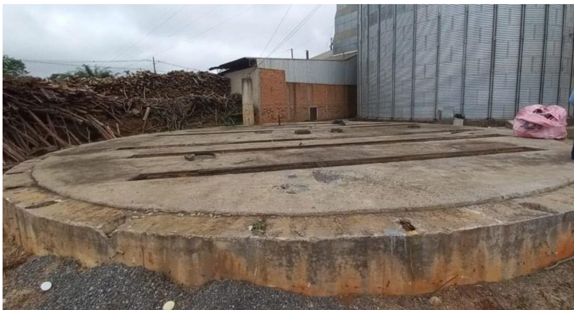
Figura 22: BASE DE UMA ESTRUTURA DE SILO
