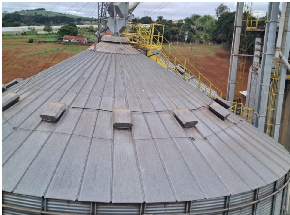
Figura 21: TOPO DO SILO GRANELEIRO
