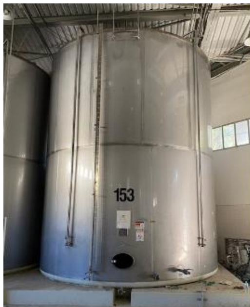
Figure 2: Boca de visita
