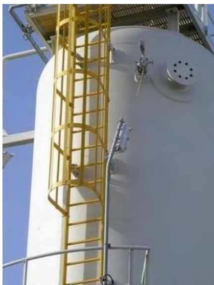
Figure 5: Plataforma com guarda corpo
