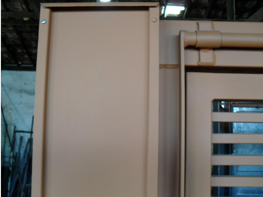
Figura 10. Portão pronto. Região das roldanas não tem fácil acesso
