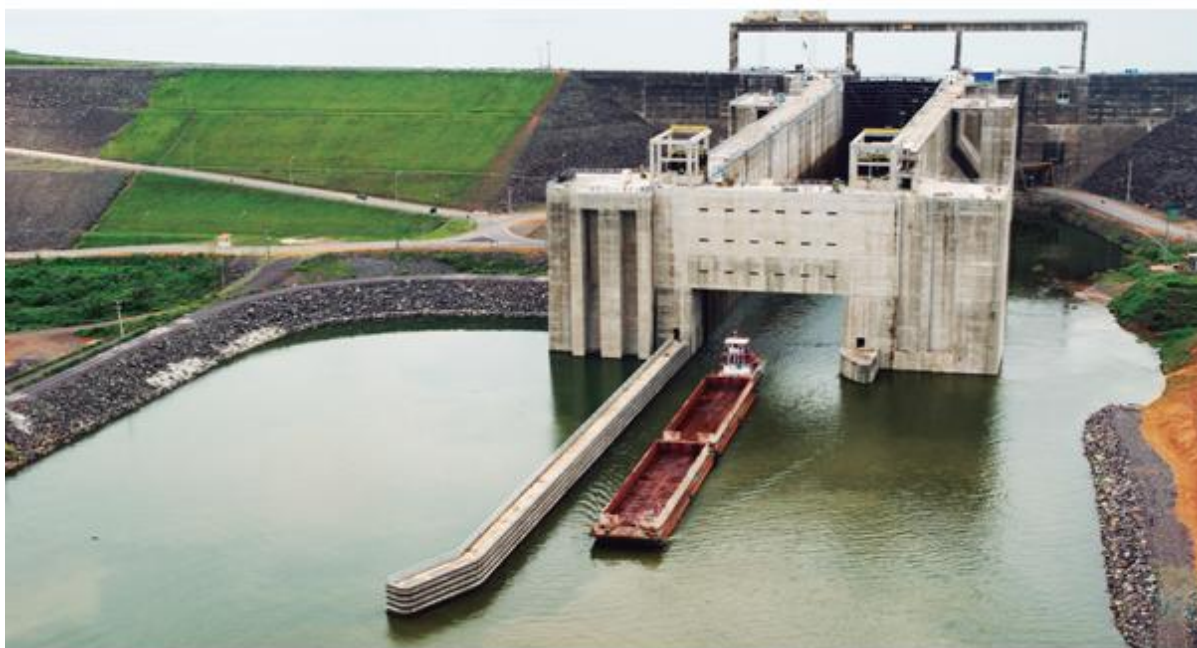
Figura 9. Eclusa de Tucuruí - PA Fonte: ANTAQ (Agência Nacional de Transportes Aquaviários)
