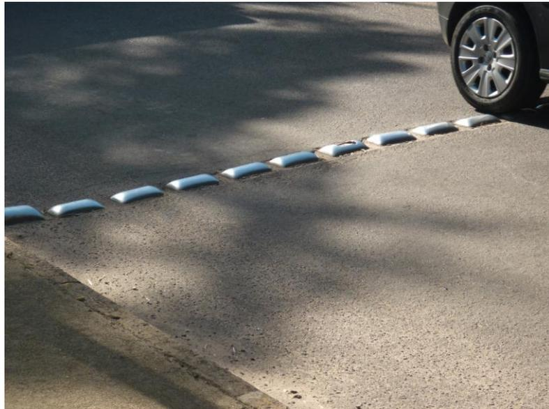
Figura 21 - Redutor de velocidade tipo II na Rua General Teles, construído com pavimento asfáltico
