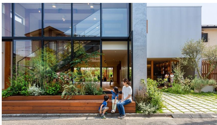
Figura 7 – AKN Nursery: Fachada
