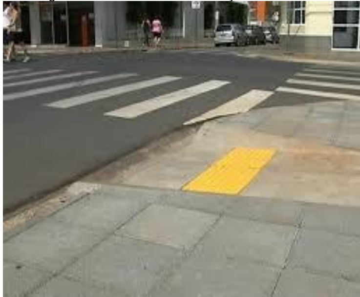
Figura 16: Pisos de alerta em calçadas rebaixadas
