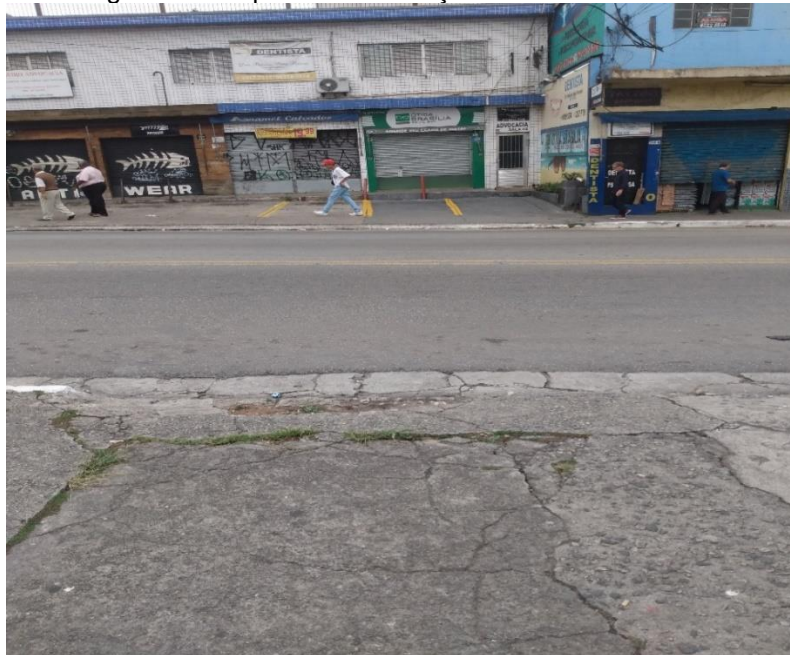
Figura 6: Rampa sem sinalização na entrada da UBS.
