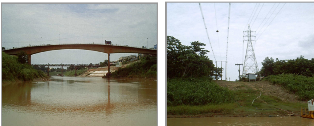
Figura 11. Ponte e rede elétrica: limitam passagem no período das cheias. Fonte: CODOMAR, 2002.
