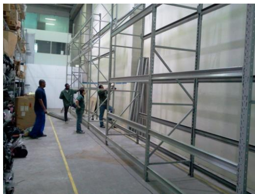
Figura 6: Armazém vista lateral. Fonte: Autores.
