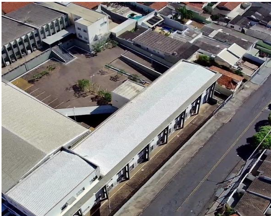
Figura 7. Visão do telhado presente no Prédio 2 da Unidade escolar
