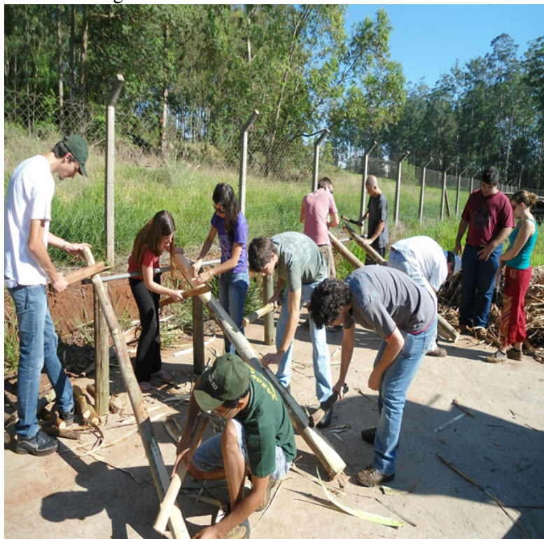
Figura 6 - Retirada das cascas dos mourões
