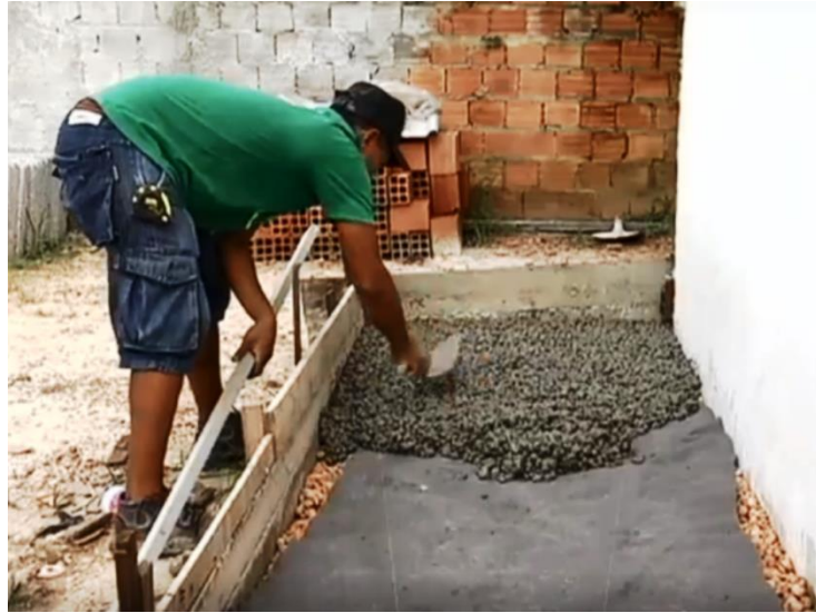
Figura 13 – Utilização do caroço de açaí na construção civil
